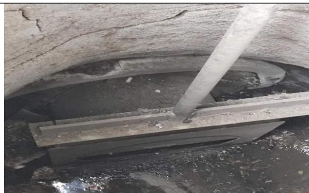
雨水外排口挡板
