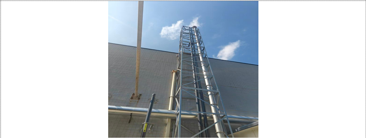
排气筒取样平台
